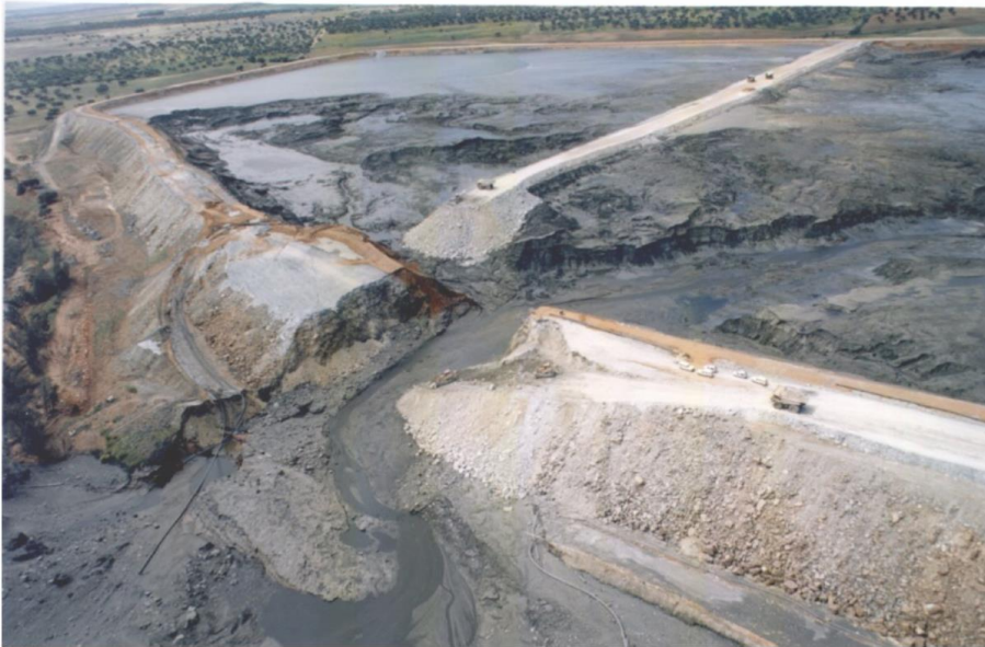
1. Vista aérea de la rotura de embalse de de Aznalcóllar (Sevilla), el 12 de mayo de 1998.
